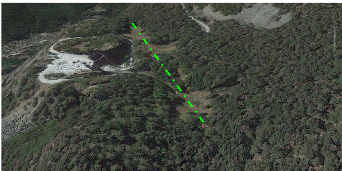
Panoramica Google Earth del settore, in verde è evidenziato il trench in contropendenza
